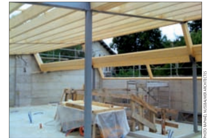
L'ossature de la charpente est en bois; l'isolant est noyé dans l'épaisseur du solivage. Une pompe à chaleur géothermique et un chauffage au sol à basse température produisent un confort adéquat.
