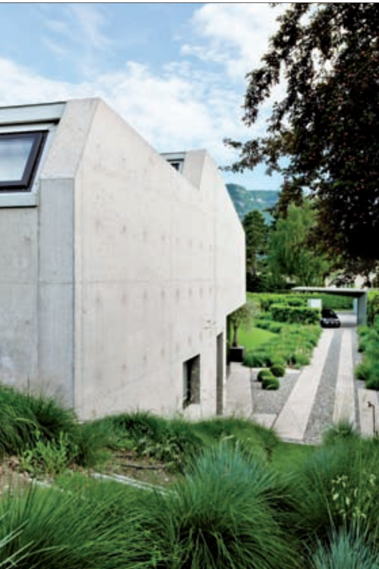
La toiture en sheds caractérise la volumétrie de la maison et lui confère un aspect très plastique. De plus, le béton brut apparent est coulé d'un seul tenant sur toute sa hauteur.
