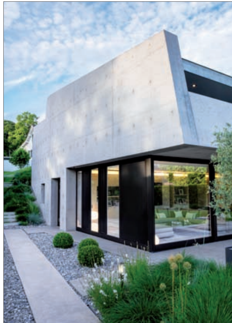
Au sud, le porte-à-faux du grand balcon procure un ombrage suffisant en été, ne nécessitant l'installation d'aucun store en extérieur.
