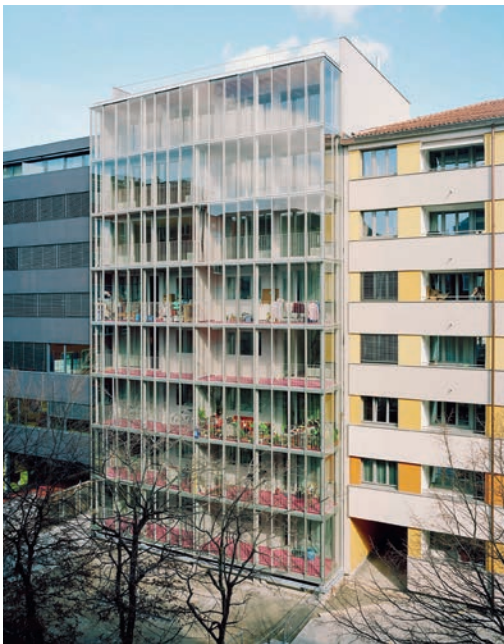
Eine ganzflächig verglaste Loggiaschicht prägt die Hofseite.
